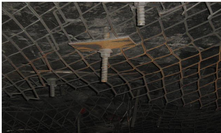
6 Сурет – Анкерлік бекітпенің орналасу схемасы
